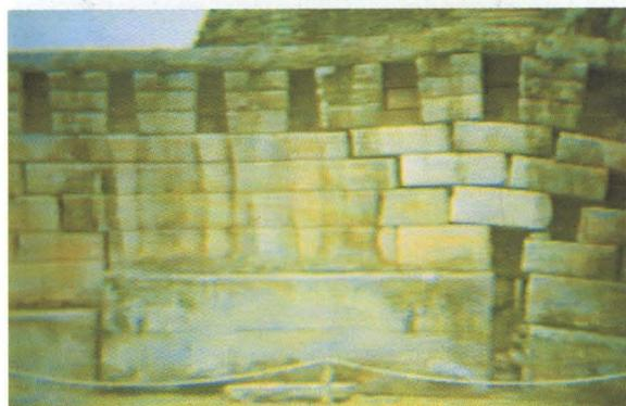
El movimiento del terreno debido a los fuertes taludes, a los movimientos sísmicos provoca asiento diferencial de las edificaciones históricas. Restos arqueológicos Incas de Machu Picchu (Perú).
