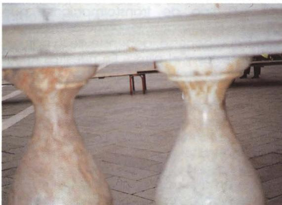
A veces los mismos procesos de restauración pueden ser causa de degradación. La aplicación de resina epoxídica como sistema de protección y su posterior despolimerización debido a la radiación solar ultravioleta ha llevado a conferir un aspecto amarillento a las zonas intervenidas en esta barandilla de la Torre del "Campanille" de la Plaza de San Marcos (Venecia).
