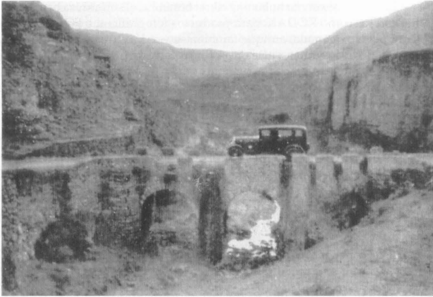
Fig. 5 – Acceso al manantial de las salinas de Cárcaba. Foto IGME, 1946.
