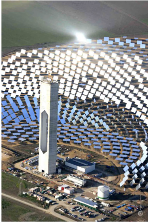
Figura 2.2: Vista aérea de la planta solar de Abengoa Solar en Sanlúcar la Mayor, Sevilla.
