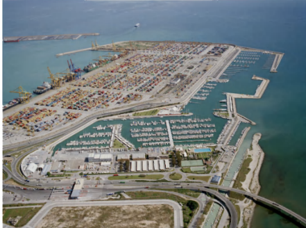
Figura 2.9: Vista aérea del puerto de Valencia.
