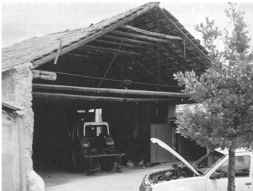
Figura 6. Vista general de la nave de molineta y almacén.
