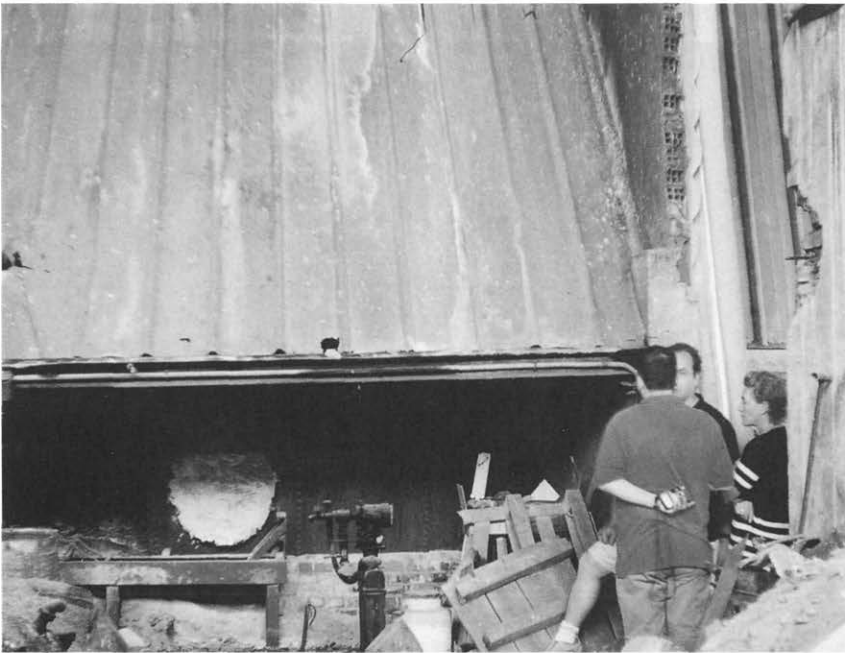
Figura 4. Campana de extracción de humos.
