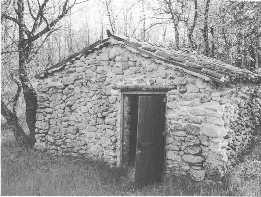
Figura 4. Casa de los caleros (Rascafría).
