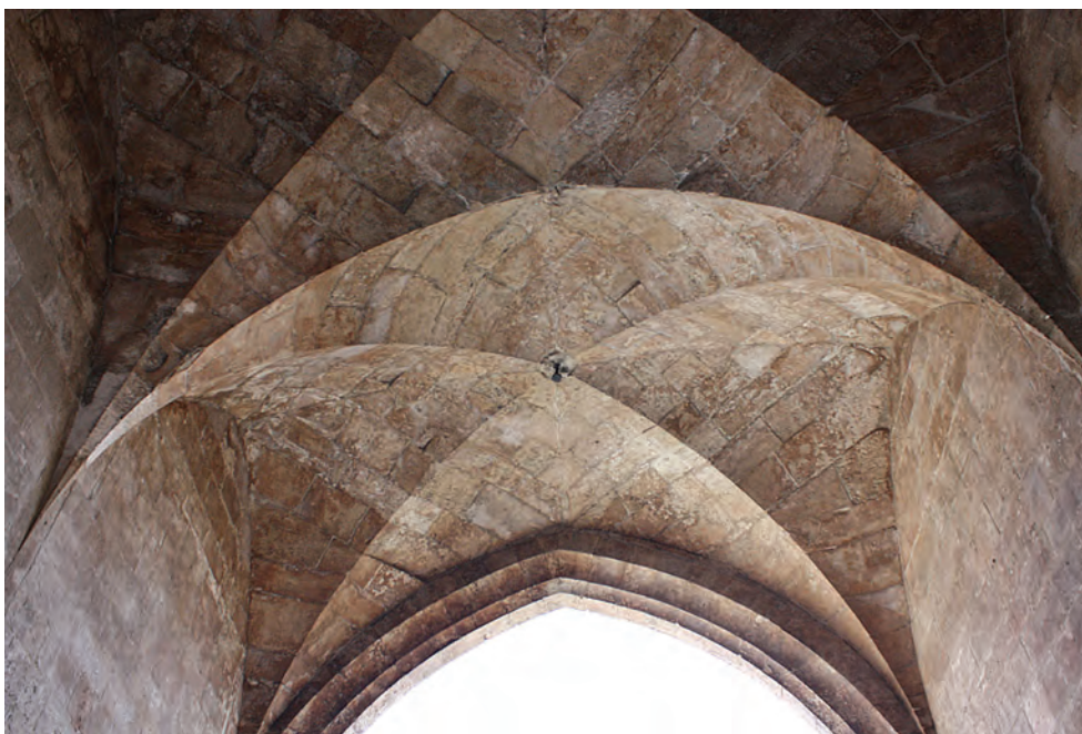
Fig. 2. Vista cenital del intradós de la bóveda aristada en la tribuna central de las Torres de Quart.
