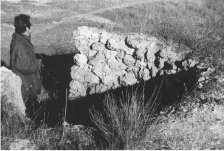
Figura 9. Caña del horno nº 4, situado a poniente de la plaza de toros.
