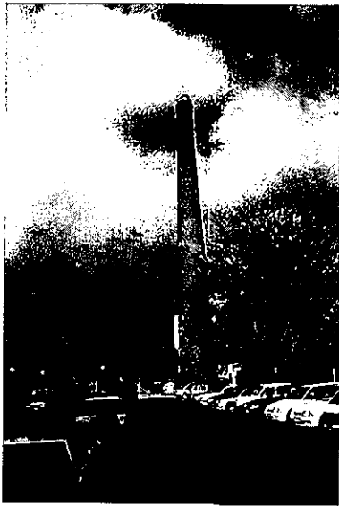
Foto 3 – Chimenea de la fábrica de Norah. Villaverde
