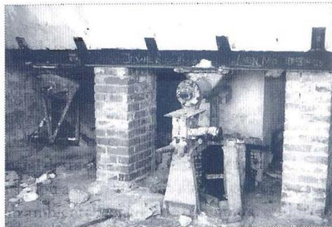
**Fig. 1** - Hangar y tolvas para cargar el yeso en la fabrica de D. Vicente Páez
