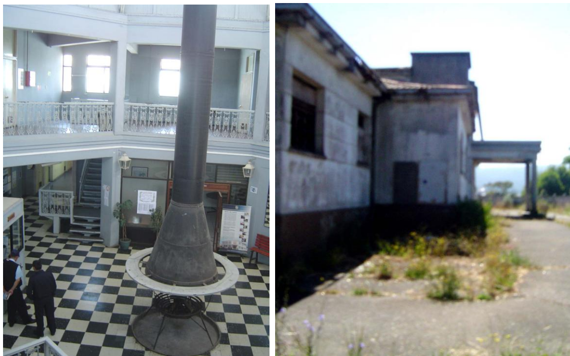
Fig. 9.13 y 9.14: A la izquierda el hall de acceso de la ex – administración. Sólo se conserva parte de la abertura del segundo nivel sobre la doble altura. A la derecha vista actual del acceso principal del antiguo hospital. Se observa el deterioro de la fachada y los espacios exteriores. Fotos tomadas por la autora, dic. 2008.
