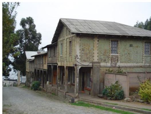
Fig. 8.15: Pabellón 81. Arquitecto Hernán Vega. Los ornamentos de albañilería de ladrillo a la vista imitan a las viviendas obreras inglesas de entramado de madera. SURPLAN 2005
