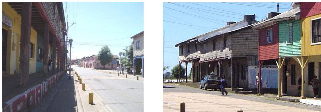
Fig. 9.10 y 9.11: A la izquierda se observa el estado de deterioro del segundo piso del pabellón 23. También están deteriorados los pilares de hormigón del corredor, cuyas enfierraduras han quedado a la vista. A la derecha el deterioro de la madera del segundo piso y los pilares del corredor del pabellón 30. Fotos tomadas por la autora, dic. 2008.
