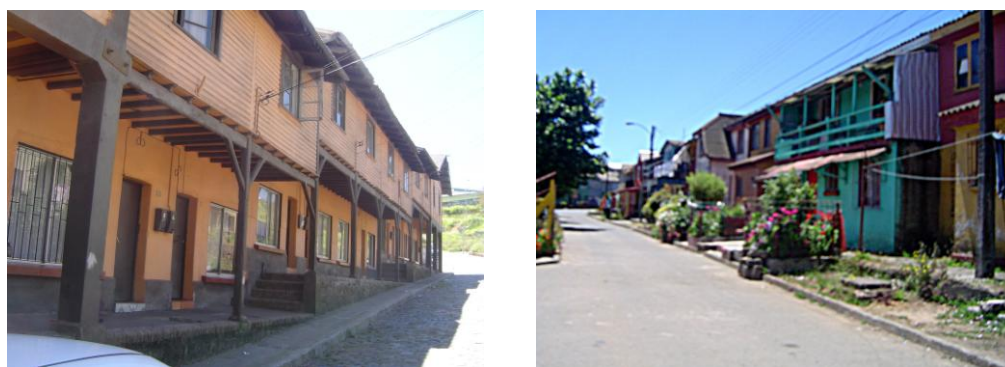
Fig. 9.6 y 9.7: A la izquierda el Pabellón 81 es uno de los que conserva la unidad original del volumen. En el Pabellón 68B, en cambio, las adiciones y las modificaciones inadecuadas de la fachada desvirtúan completamente la unidad del pabellón. Fotos tomadas por la autora, dic. 2008.
