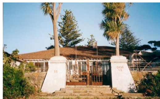
Fig. 8.19: Casa de Huéspedes. Fuente I. Municipalidad de Coronel.
