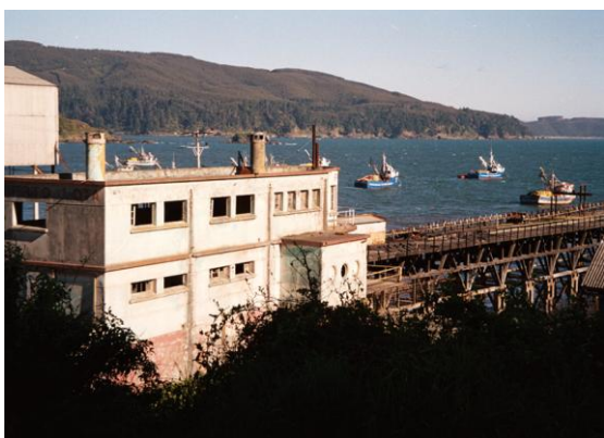
Fig. 8.20: Muelle de Lota e instalaciones portuarias. Muelle es de acero, de 286 m de largo. Fue el primero en Chile con cargador móvil construido en Estados Unidos. Fuente SURPLAN, 2005
