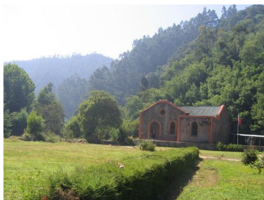
Fig. 8.29 Central Hidroeléctrica Chivilingo. Fuente www.biobiosur.cl
