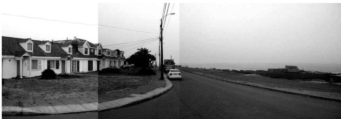
Fig. 9.5 Vista de una hilera de viviendas para empleados frente al mar en Maule. Se observa el buen estado de las viviendas, que contrasta con el estado de abandono del chiflón en la playa; y los antejardines y espacios abiertos en la costanera. Fotos tomadas por la autora, enero 2009.
