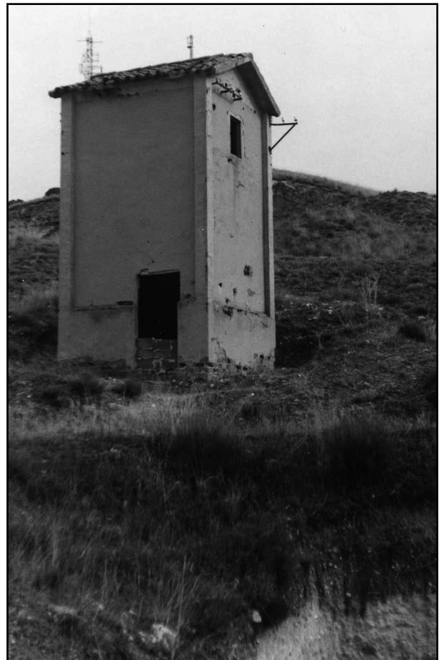
Figura 4. Vista del transformador.
