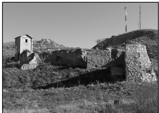
Figura 2. Vista general de las instalaciones YECESA.
