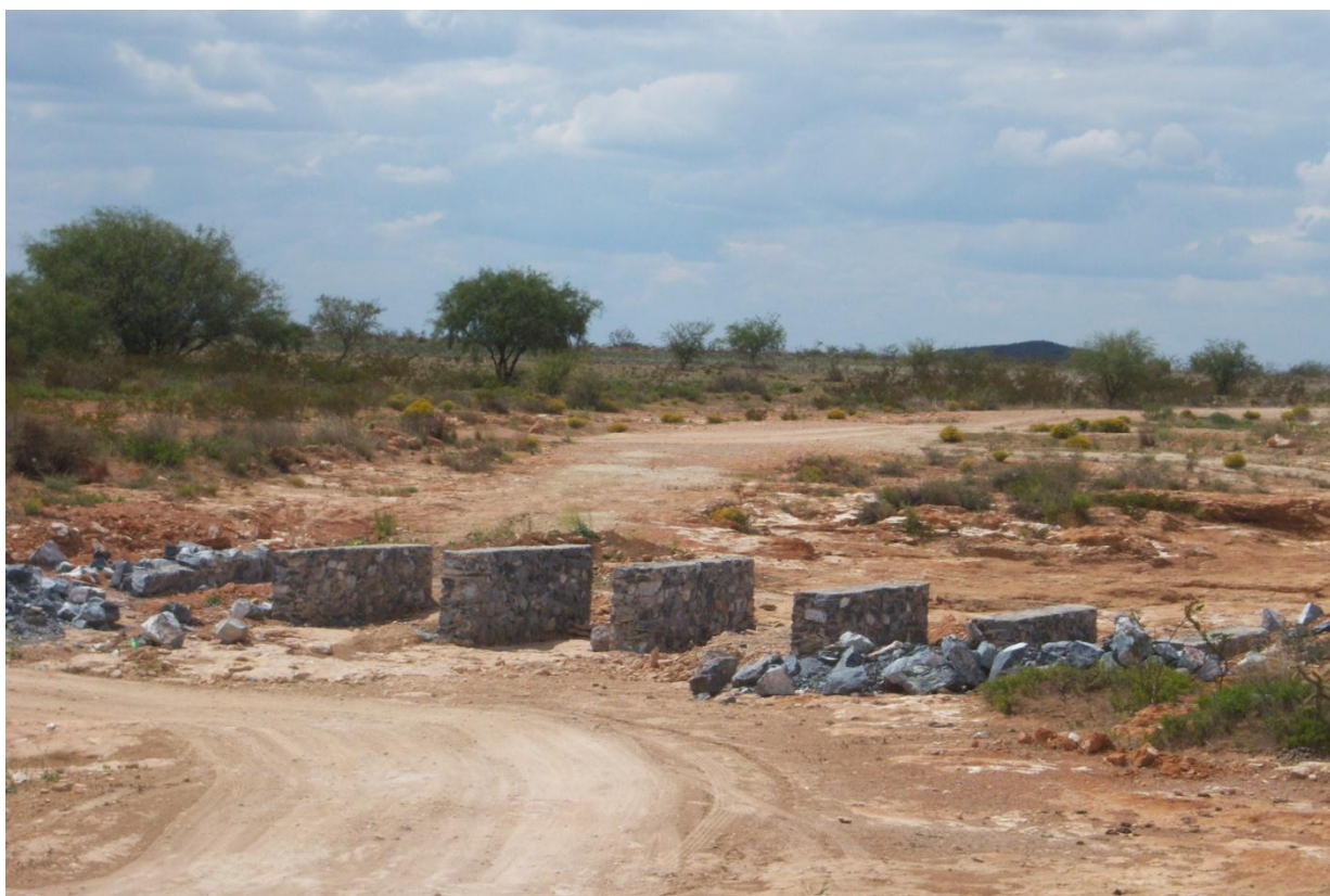
Figura 6. Camino y construcción de paso de cruce de avenidas pluviales incompleto.
