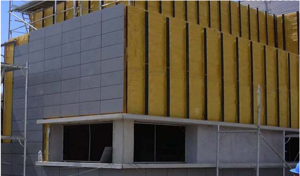
Fig. 4.6b. Fachada ventilada de juntas abiertas Ston-ker, Porcelanosa. (Imagen A. Bosqued)
