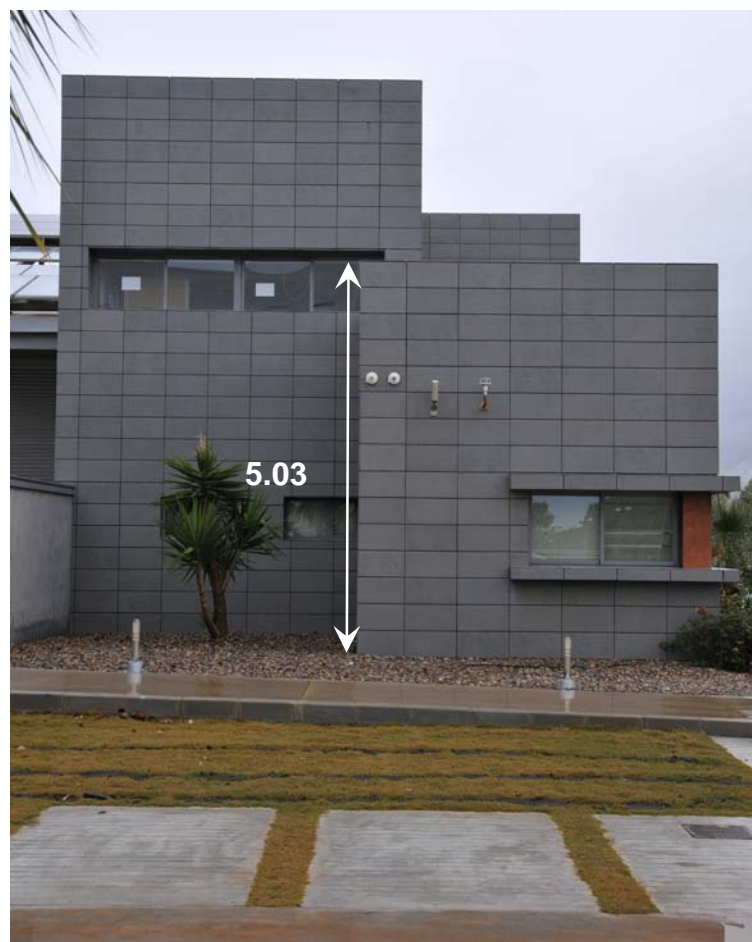
Fig. AII.1. Altura total fachada ventilada de juntas abiertas objeto de estudio
