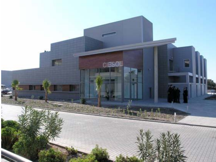
Fig. 4.2. Vista fachadas Norte-Este del edificio CIESOL de la Universidad de Almería. (Imagen A. Bosqued)
