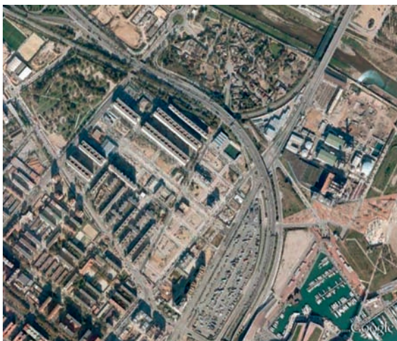
Imagen 6 Estado de las obras en noviembre de 2007
