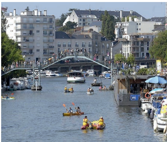
Imagen 8 Vista del canal Fuente: SAMOA
