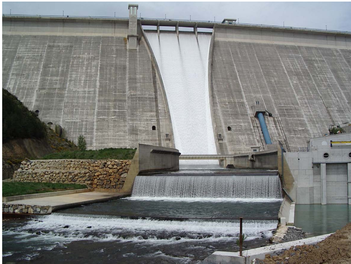
Fotografía nº1.- Imagen de la presa vertiendo por el aliviadero
