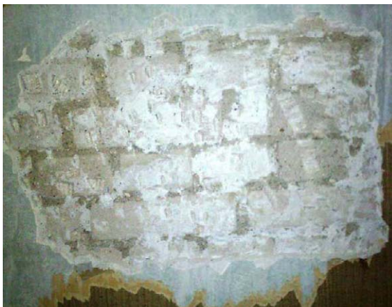
Cala en muro de carga de fábrica de ladrillo Figura nº 19
