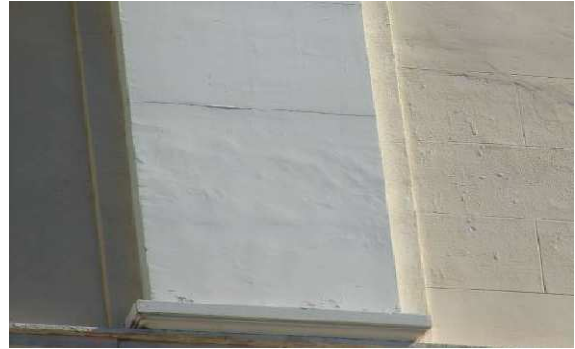
Reparaciones en revestimiento de mortero Figura nº 10
