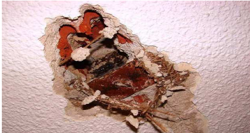
Cala en cara inferior de forjado Figura nº 16
