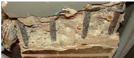
Cala en cara inferior del cargadero de hormigón armado Figura nº 17
