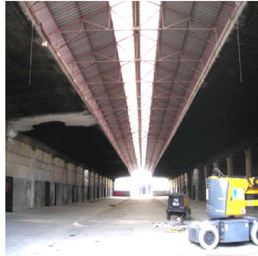
Vista de los voladizos de cubierta Figura nº 2
