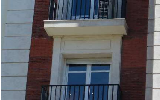
Reparaciones en fachada de ladrillo cara vista Figura nº 9
