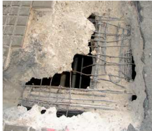
Calas realizadas para descubrir la armadura de negativos de los forjados Figura nº 11
