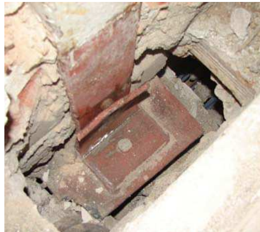
Vista desde la planta superior del pilar metálico que ha sufrido el descenso durante el refuerzo de la planta octava Figura nº 12
