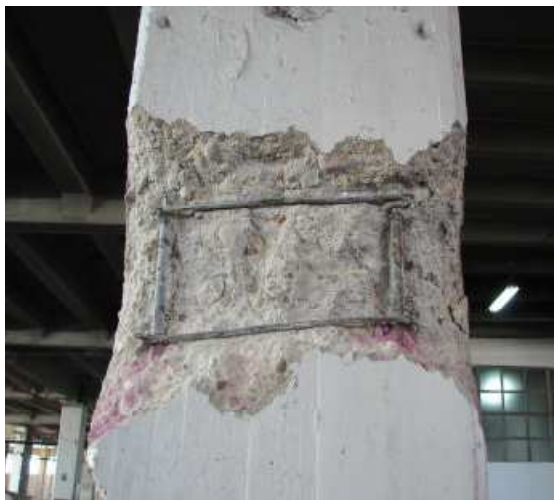
Calas realizadas en pilares de hormigón Figura nº 16
