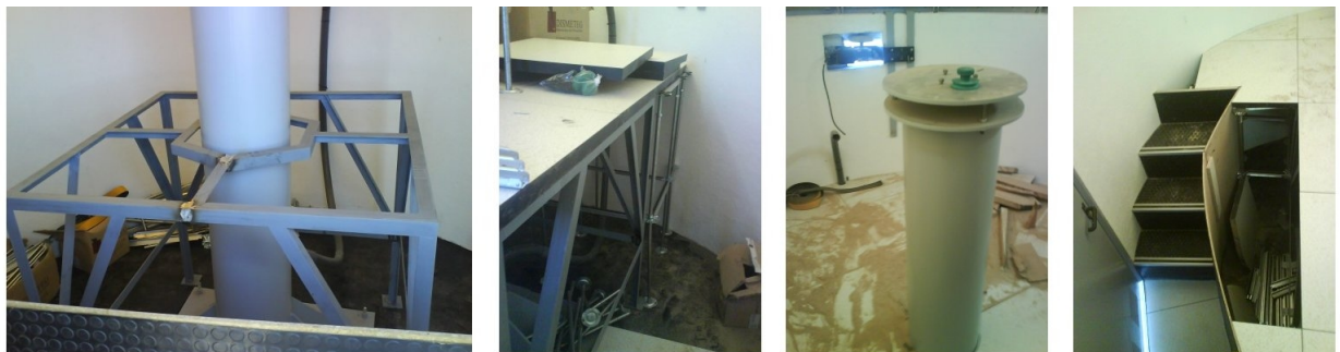
Figura 3.8: Observatorio Montegancedo: montaje del suelo técnico
