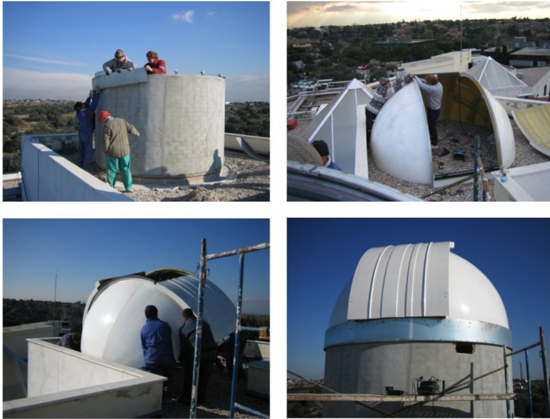
Figura 3.6: Observatorio Montegancedo: montaje de la cúpula
