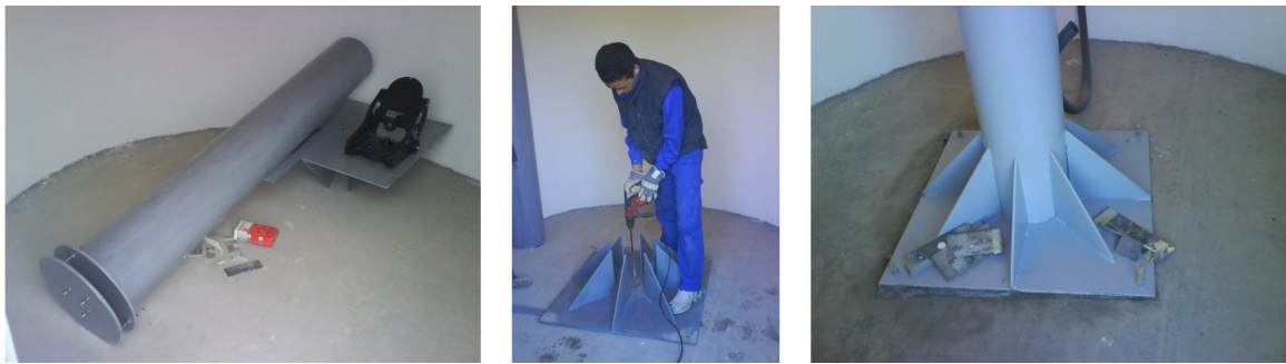
Figura 3.7: Observatorio Montegancedo: montaje del pedestal
