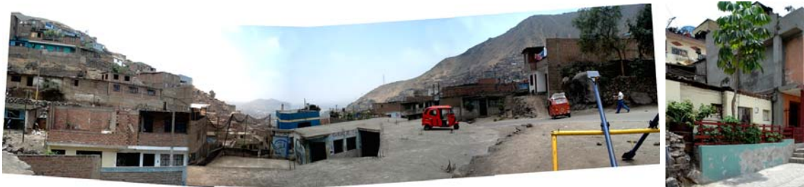
Imagen 7. Espacio expandido en asentamiento en ladera: calle-espacio deportivo-expansión de espacio público, sobre cubierta de centro cívico. Independencia-Lima. Fotografía de los autores
