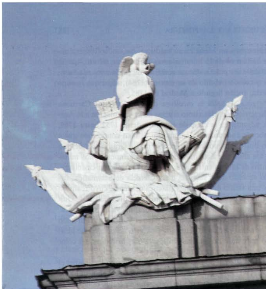
FIG. 247.—Detalle de la parte superior de la Puerta de Alcalá de Madrid. (Foto Sánchez-Durán)
