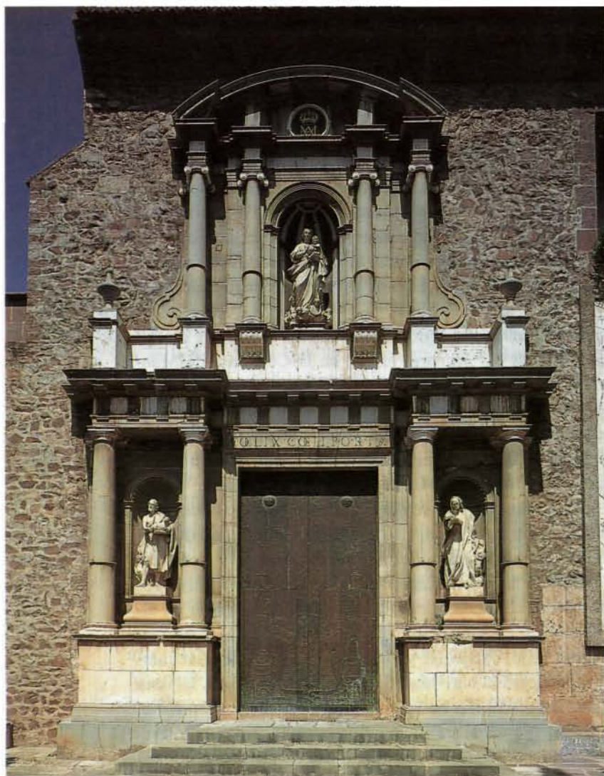
FIG. 253.—Fachada de la iglesia de la Cartuja de Portacoeli. Valencia. (Foto Oronoz)
