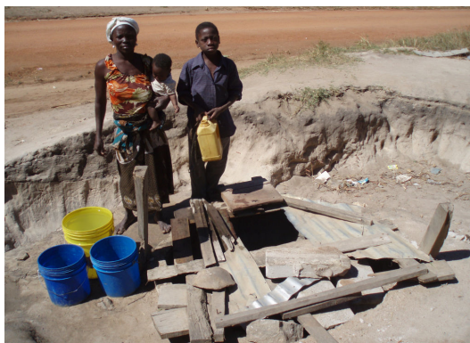
Figura 11 Pozo en condiciones precarias
