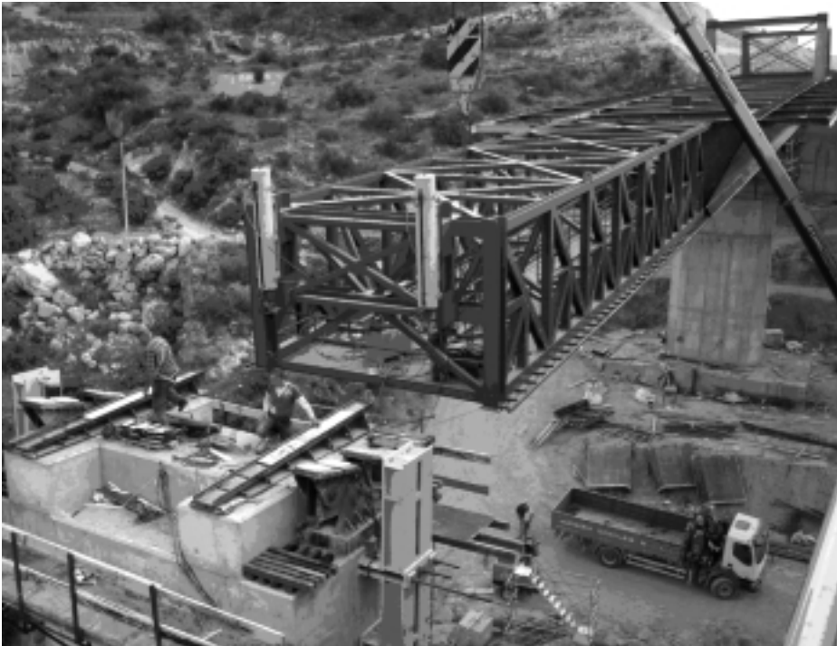
FIGURA 45: LANZAMIENTO DEL VIADUCTO DE CAÑIZARES (2008). PROYECTO MCA. CONSTRUCTOR METÁLICO Y DE OBRA CIVIL: ACCIONA. EN PRIMER PLANO SOBRE LA PILA: APOYO BULONADO.
