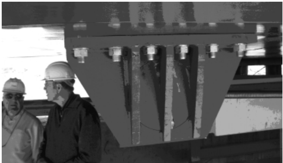
FIGURA 47: UNIÓN ATORNILLADA DEL AMARRE DE RETENIDA DEL MISMO PUENTE.
