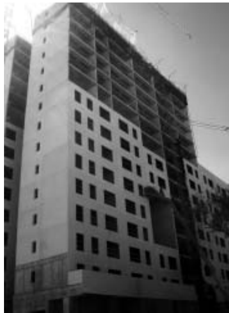
5. Edificio de 20 plantas: montaje de los paneles arquitectónicos de fachada.
