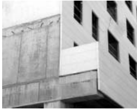
17. Detalle del peo que corona el pórtico de planta baja. Fachada este.
