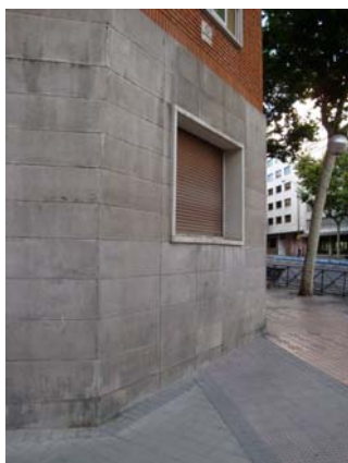
Fig. 10. Chapado de zócalo de piedra artificial. Fig. 11. Fisuras en chapado de piedra artificial
