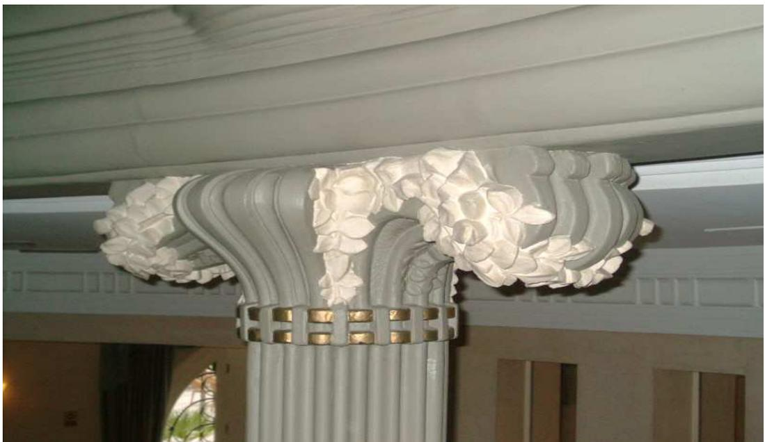
El material de piedra artificial, realizado con cemento Pórtland y arena sílicea, es de una extraordinaria dureza y calidad, resultando por el contrario
