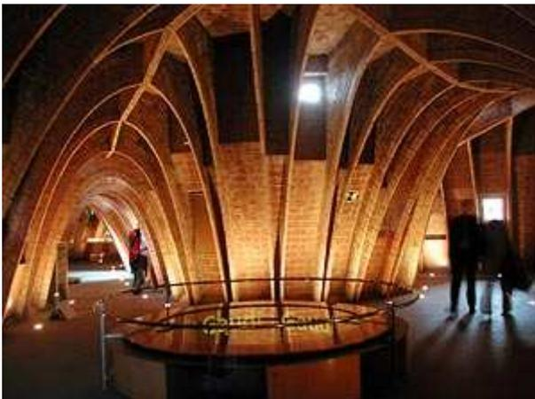
Las bóvedas, resueltas en fábrica, que solucionan la cubierta.
