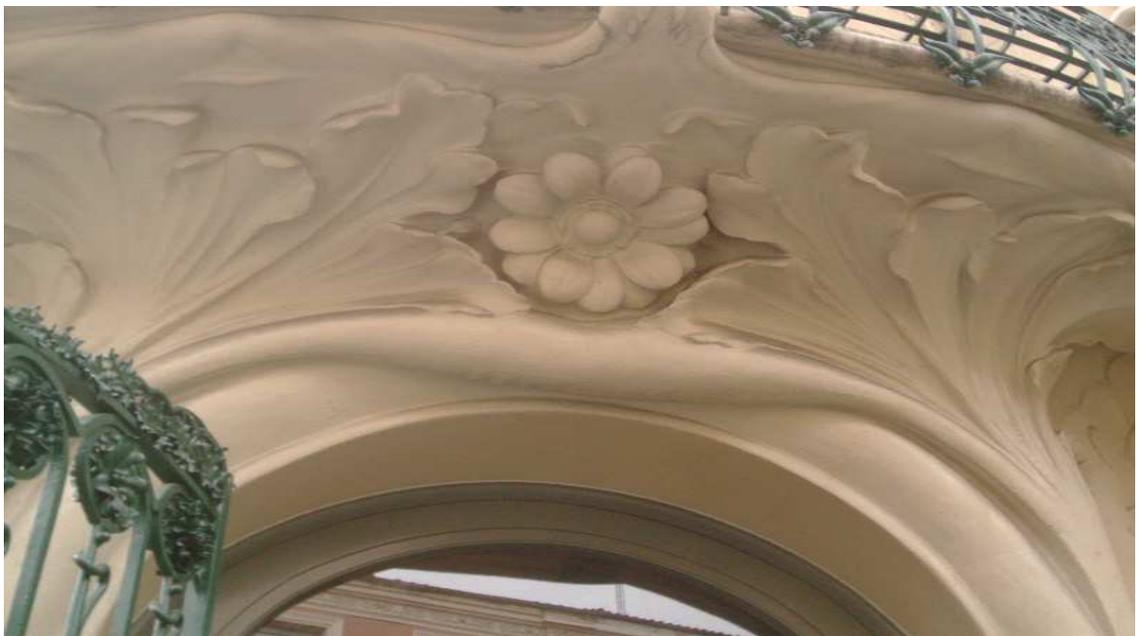
Se ha confirmado la existencia de una primitiva capa de revestimiento sobre los prefabricados de piedra artificial, revestimiento realizado mediante estucos de yeso y caseína cuya entonación cromática corresponde al color siena claro, pigmento procedente de la tierra natural utilizado en la composición de buena parte de los revocos madrileños y mediterráneos en general
