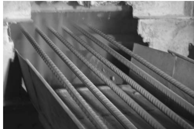
Figura 2. Proceso de recubrimiento de las armaduras mediante aplicación de un spray cargado electrostáticamente
