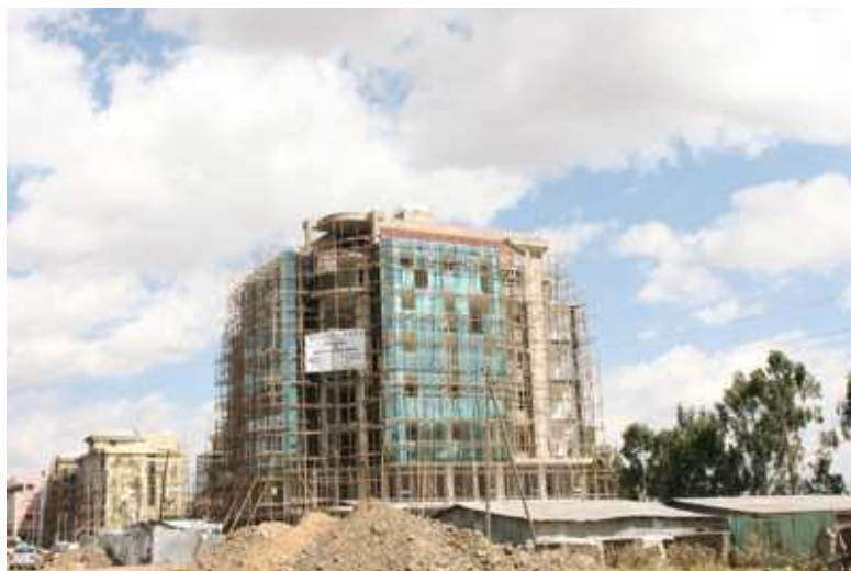
Figura 4.8: Madera en rollo empleada para la construcción, Addis Abeba
