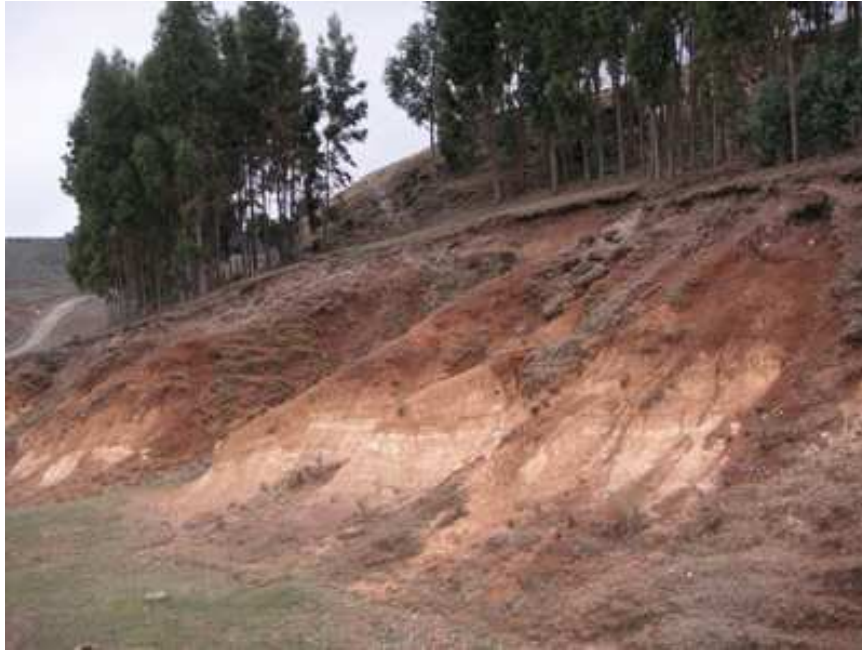
Figura 5.10: Erosión hídrica y cubierta vegetal
