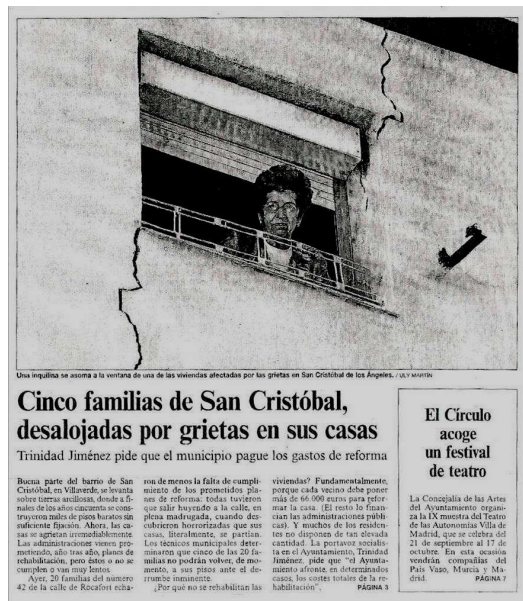
Figura 2: Repercusión de los problemas estructurales (9)
