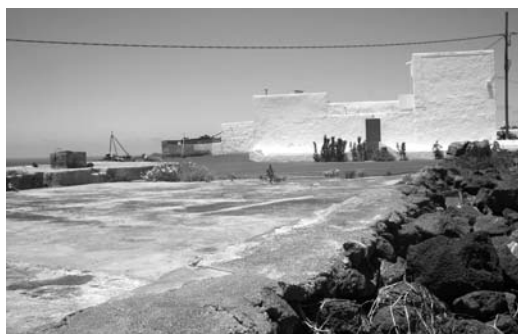
Figuras 8 Vivienda, acogida y aljibe en Las Breñas
