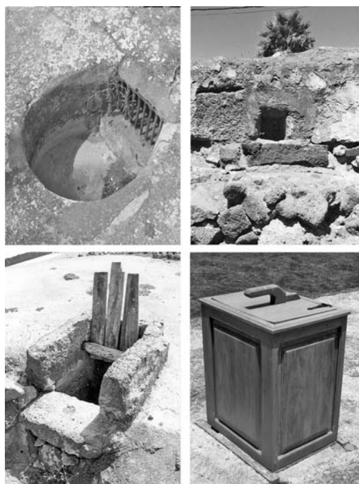
Figura 10 Elementos de los aljibes: caño con coladera en San Bartolomé, aliviadero en San Bartolomé, brocal en Güime, brocal de madera en Mancha Blanca
