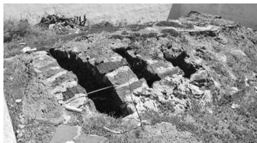
Figura 12 Arcos fajones que conforman la bóveda del aljibe en San Bartolomé
