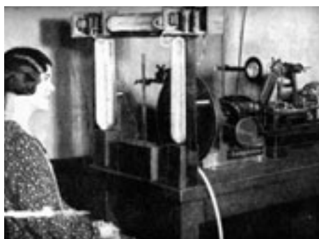
Figura 27. Aparato transmisor empleado por Ives en la demostración de 1927. La luz, generada por un arco de luz situado en el extremo derecho, pasa a través de una lente y llega hasta el disco de Nipkow, que se encarga de generar el «flying spot». El reflejo es captado por las tres fotocélulas, alargadas y de color claro, que se encuentran en los laterales y en la parte superior; frente a la señorita. Fuente: Sheldon-1929.
