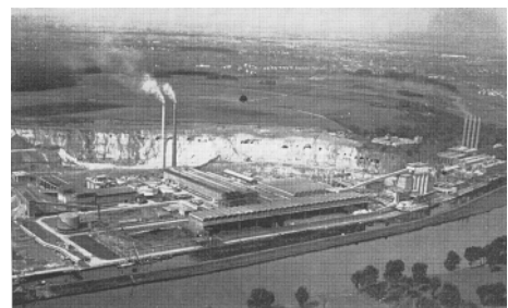
Fig.10 – Vista tras la tercera ampliación con el nuevo silo vertical a la derecha
