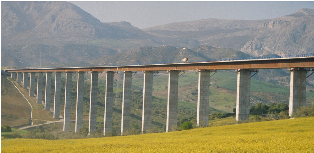
Figure 1: "Arroyo de las Piedras" viaduct.
