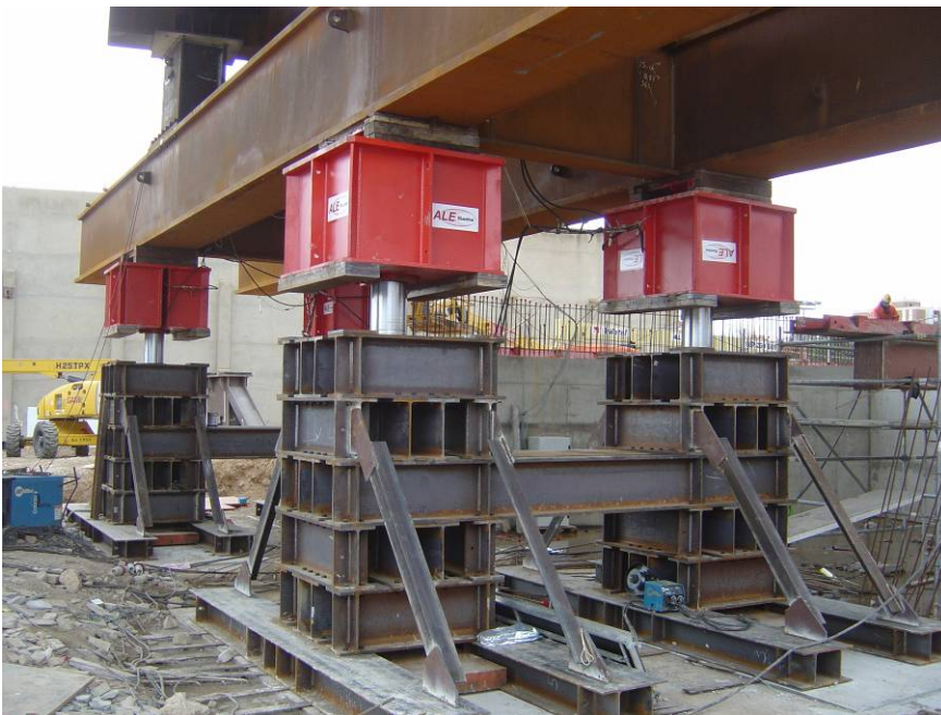
Fig.XX Estructura utilizado para el gateo (descenso) de la parte trasera de la estructura.
