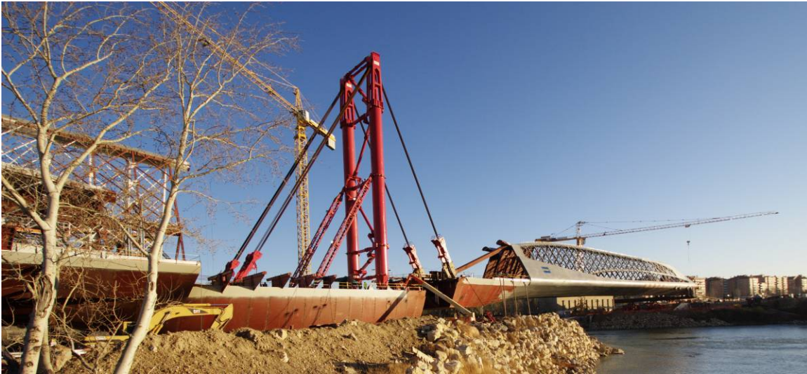
Fig.XX Vista de una de las etapas de la segunda fase del lanzamiento desde la margen izquierda.
