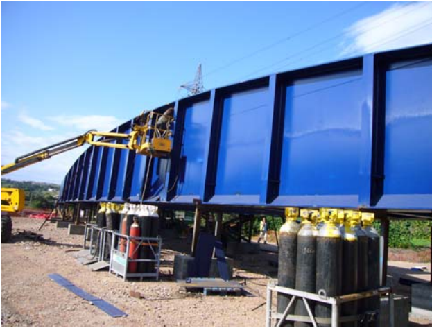
Figuras 9 y 10. Rigidizadores y vigas transversales.
