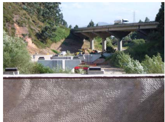
Figura 12. Paso de la estructura del eje 1 bajo el viaducto de la autopista
