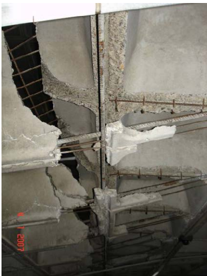
Fig. 4. Izquierda: Rotura por nervio del reticular
