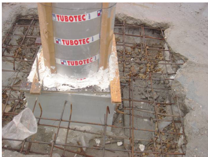
Fig. 10. Izquierda: Reparación de la solera.
