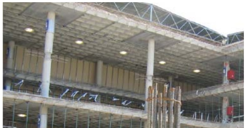
Derecha. Pilares de doble altura en situación provisional del M - C.
