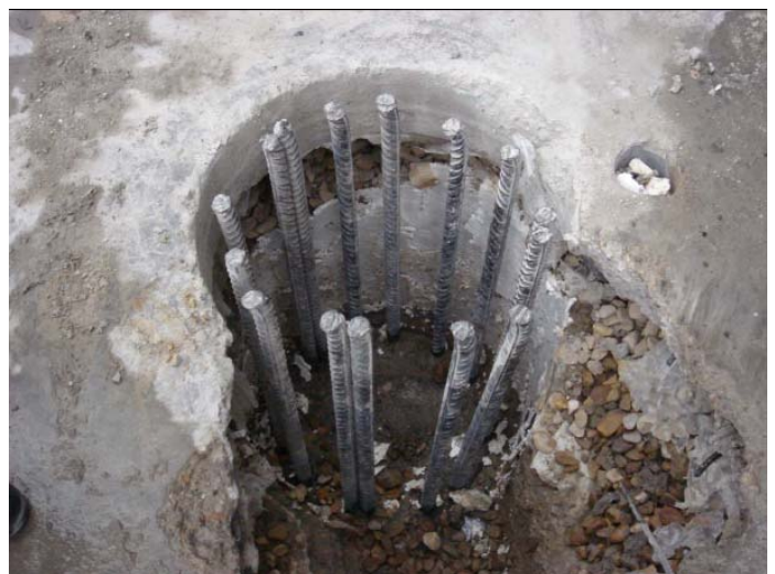
Derecha. Estado de esperas de pilares cortados a nivel de solera
