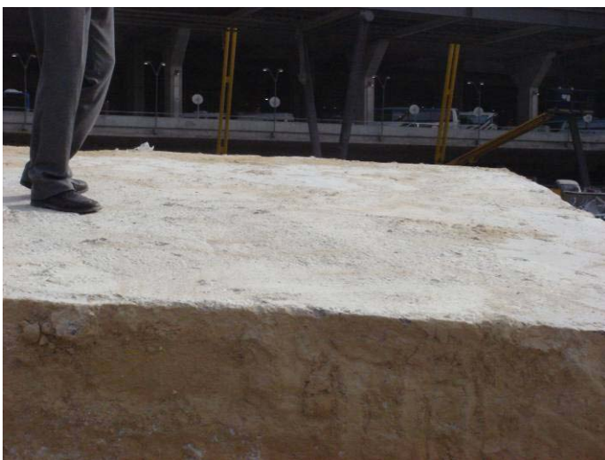
Fig. 9. Izquierda: Cara Inferior de zapata.
