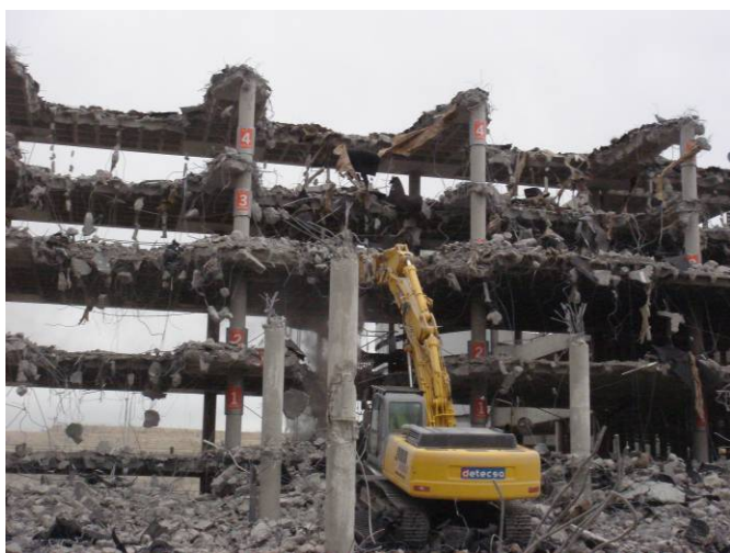
Fig. 6. Izquierda: Demolición de los forjados
