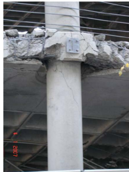
Derecha. Detalle de zuncho de borde
