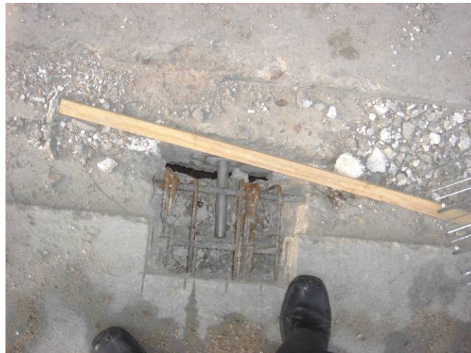
Derecha. Cajeadado para hormigonado en 2 fase de conectadores
