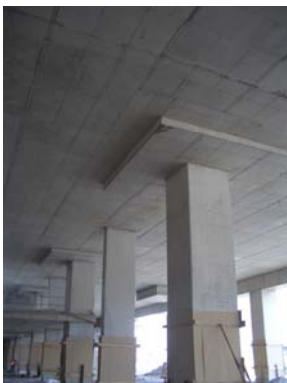
Fig. 4 Vista de los ábacos terminados
