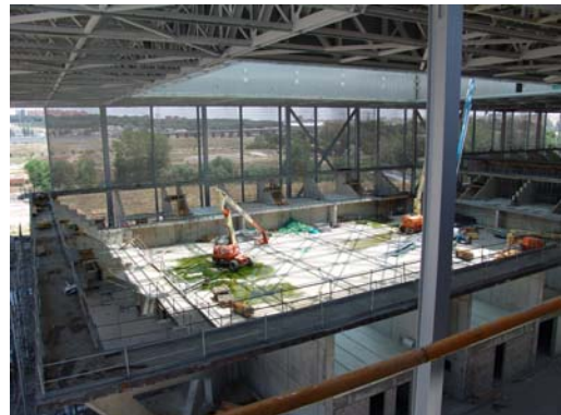
Fig. 29 Interior del Estadio 2
