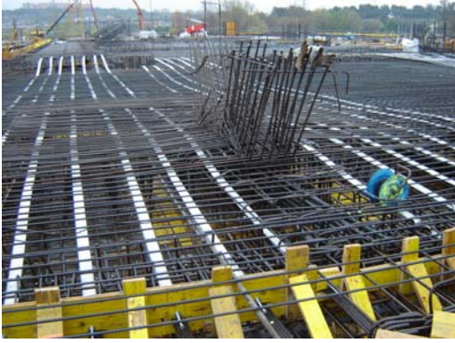
Fig. 6 Armado de losa nivel 571.20
