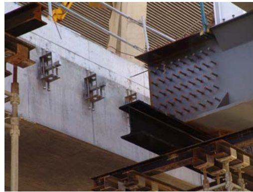
Fig. 3 Junta entre estadio 1 y pasarela
