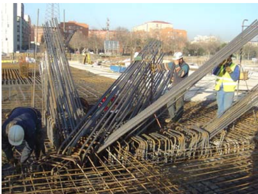
Fig. 10 Detalle arranque de pórticos antes de hormigonar
