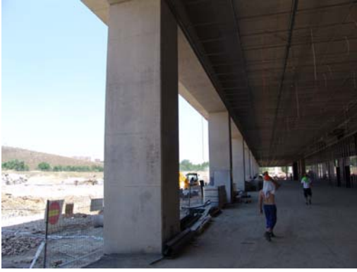
Fig. 14 El techo plano sin vigas descolgadas facilita el montaje de instalaciones
