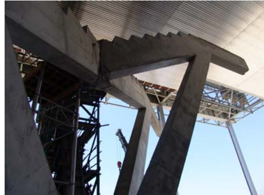
Fig. 27 Encuentro en pórtico de esquina
