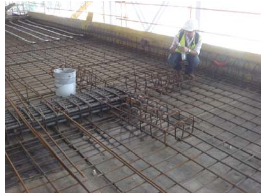
Fig. 21 Armado del Sky-Lounge, se aprecia la armadura superior del pórtico y la dimensión del voladizo
