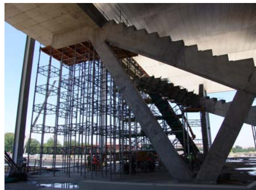
Fig. 25 Pórtico tipo terminado y ejecución de la losa del Sky-Lounge
