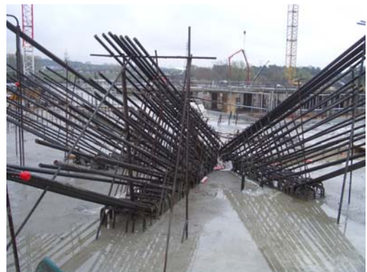
Fig. 11 Detalle arranque de pórticos tras el hormigonado
