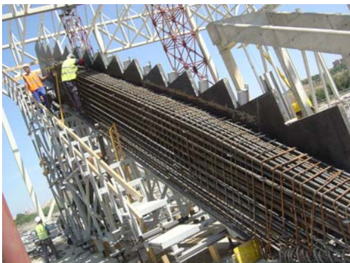
Fig. 24 Ferralla de primera fase de pórtico tipo
