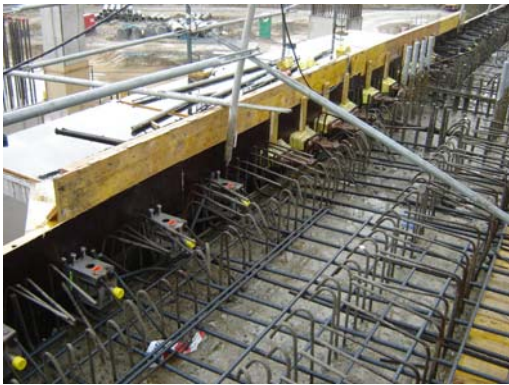
Fig. 2 Junta entre estadio 1 y estadios 2 y 3
