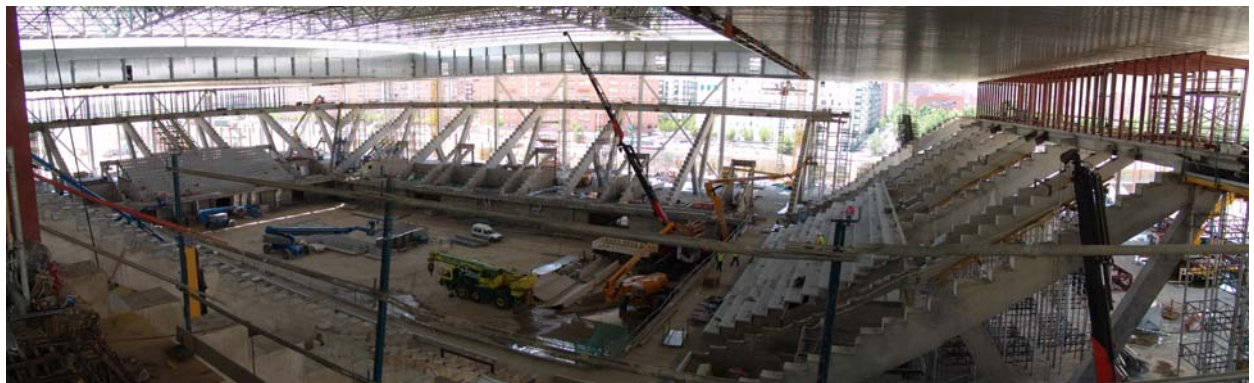
Fig. 30 Interior del Estadio 1 donde se aprecian los pórticos terminados
