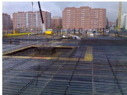
Fig. 5 Ferrallado de los ábacos
