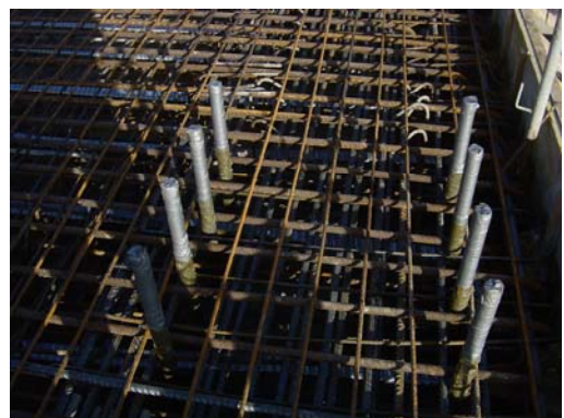
Fig. 13 Detalle arranque de pilares de cubierta
