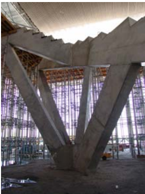
Fig. 28 Vista de pórtico de esquina con dos pórticos ortogonales
