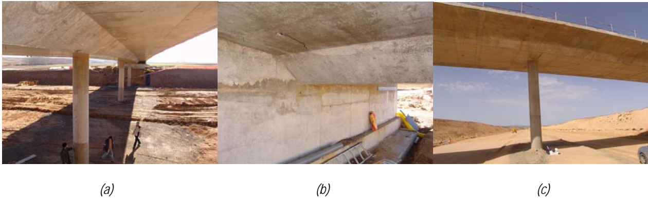
Fig. 1 Fotos del puente instrumentado. a) Vista inferior desde el estribo 1. Tablero rígidamente unido al estribo (b). Pila empotrada en el tablero (c).
