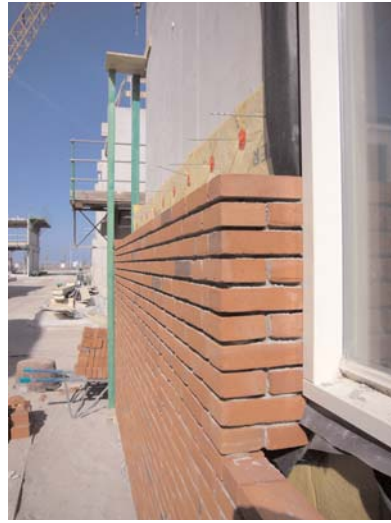
Muro exterior de varias capas, la exterior con ladrillo colocado de forma tradicional. Ijburg, Holanda, 2007
