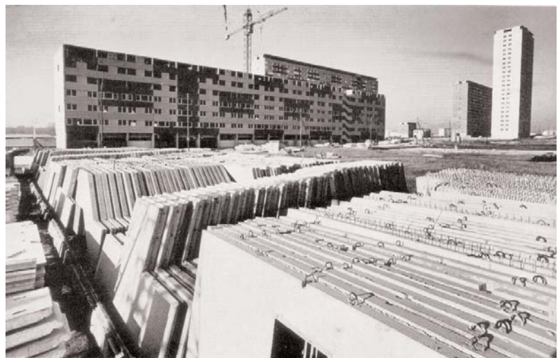
Acopio a pié de obra de grandes paneles de la patente Tracoba, Francia
