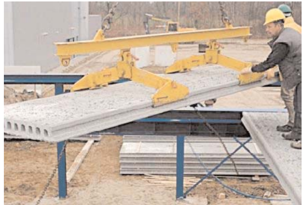
Prelosa para la construcción del forjado
