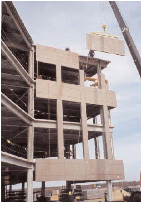
Colocación de paneles prefabricados de tamaño medio
