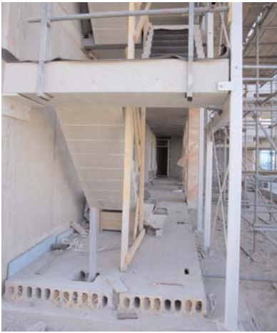
Escaleras prefabricadas, cocinas y elementos de tabiquería en viviendas. Ijburg, Holanda, 2007
