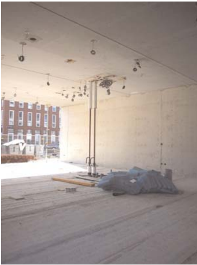
Instalaciones de fontanería y electricidad para edificios de viviendas. Kits de saneamiento. Ijburg, Holanda, 2007
