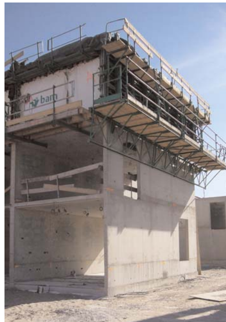
Encofrados tipo túnel para viviendas. Ijburg, Holanda, 2007.
