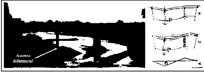
Fig. 6. Asiento diferencial: un síntoma relativamente fácil de detectar y caracterizar (foto de los autores).
