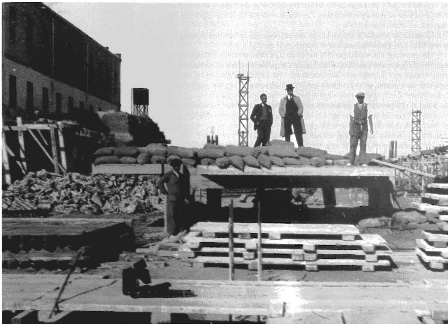
6. Prueba de carga del tramo de losa ensayado a escala real.
