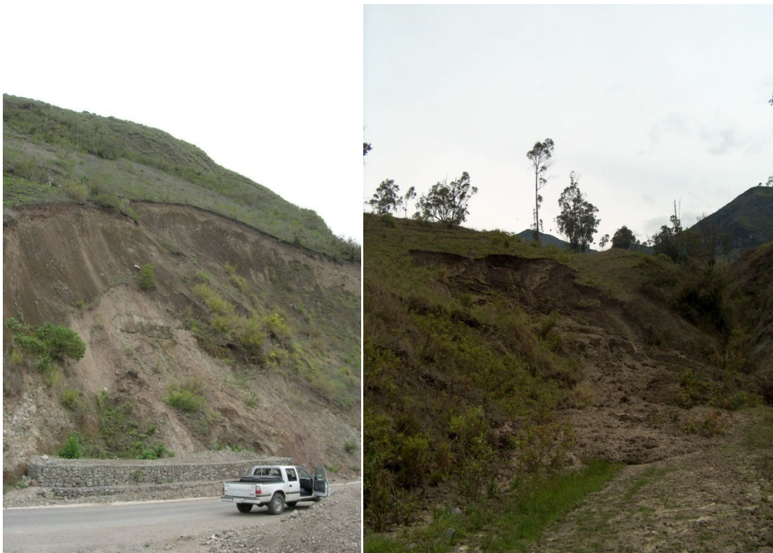
Ilustración VI.3: Deslizamientos en carretera Panamericana (izquierda) y en el camino que une Piñancay con Verdepamba (derecha).
