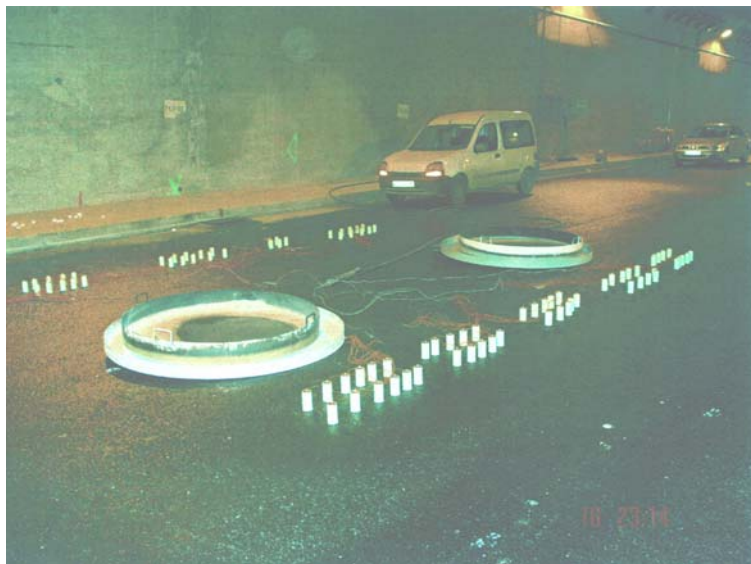
Imagen 5.2: Vista de la sección del ensayo en el túnel 2.
