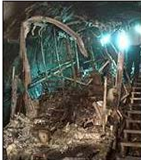
Imagen 1.5: Incendio de Kaprun, 13 de noviembre del 2000
