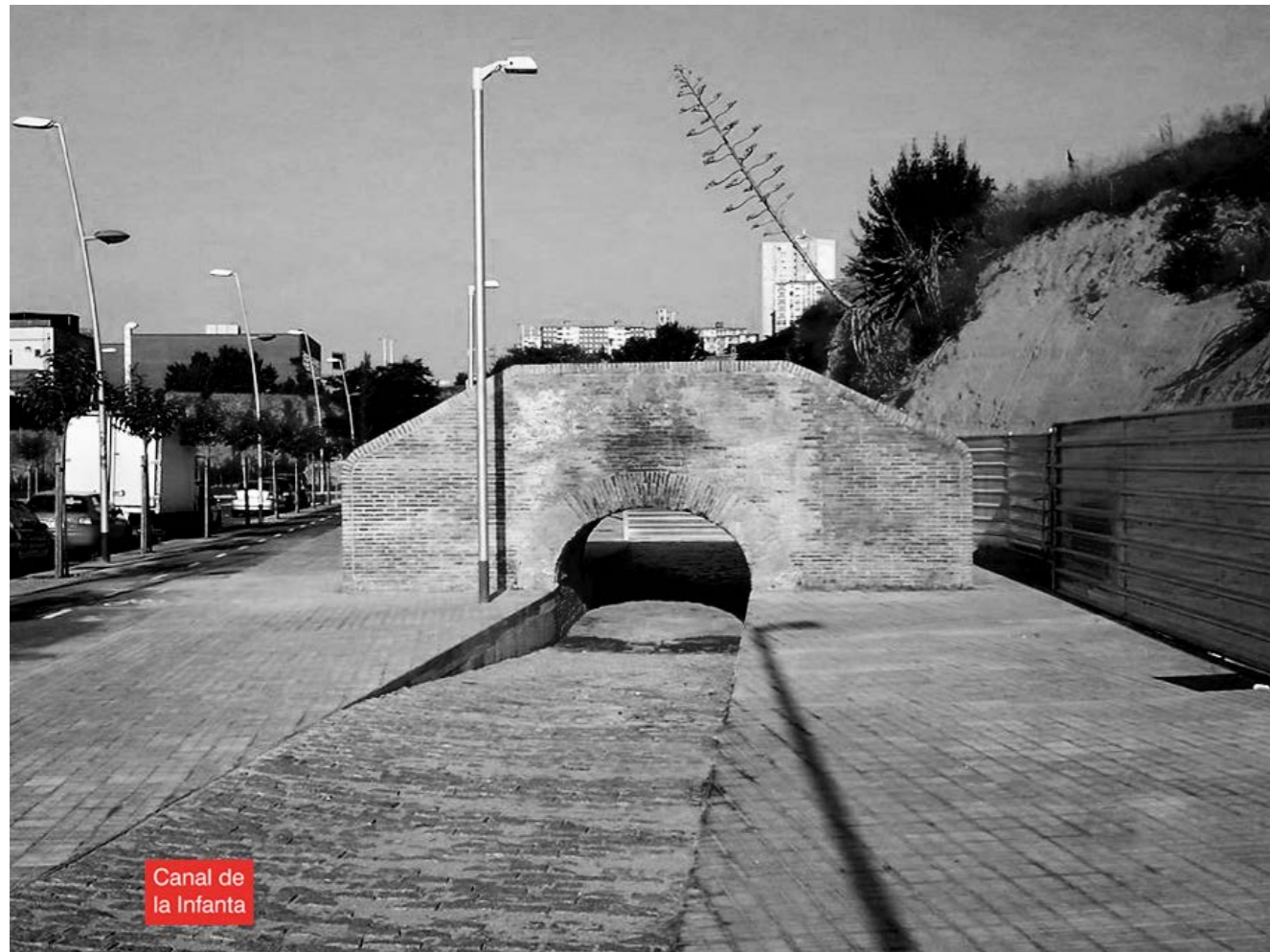
FIG. 3.10 Puente sobre el Canal de la Infanta en el ARE de la Remunta. Fuente: PERSEU (Edición y anotación del original) A pesar de que la movilización de la sociedad civil consigue "salvar" el puente y que pavimenten de forma singular el trazado del canal, el resultado final dista mucho de ser un ejemplo en la revalorización patrimonial.
