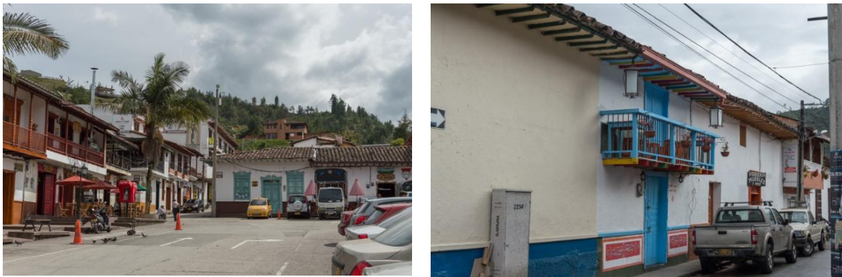
Figura 5.99. Balcón como elemento representativo de la arquitectura en el municipio de El Retiro, Antioquia
