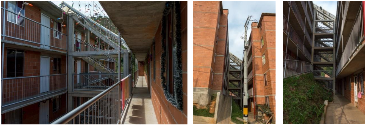
Figura 6.31. Distanciamiento entre edificaciones del conjunto n°7, Hispania
