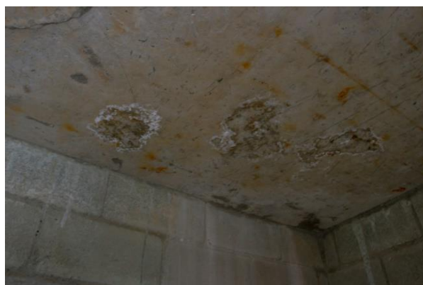
Figura 6.14. Humedades presentadas en los conjuntos n°2 y 4, Fredonia y Yarumal
