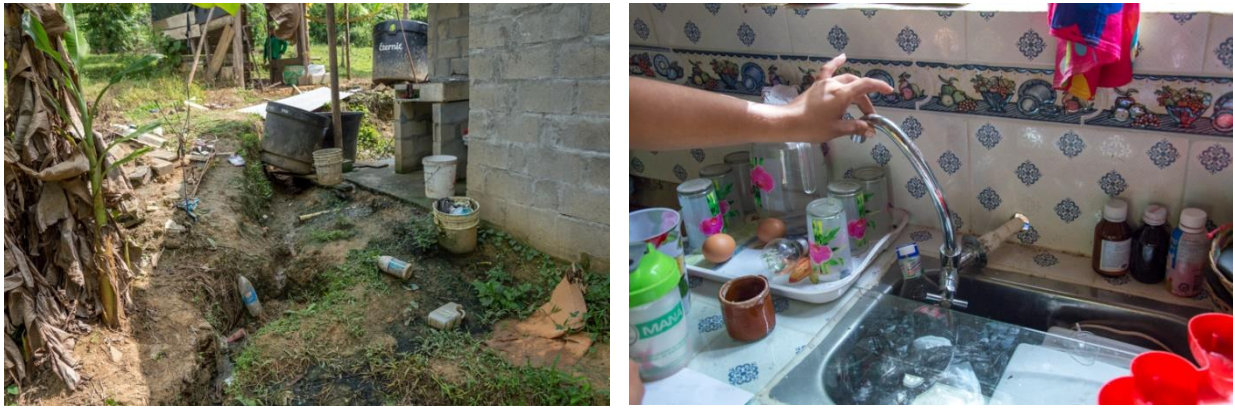
Figura 6.46. Desconexión de ductos en saneamiento y acueductos en viviendas n°1 y 5, respectivamente
