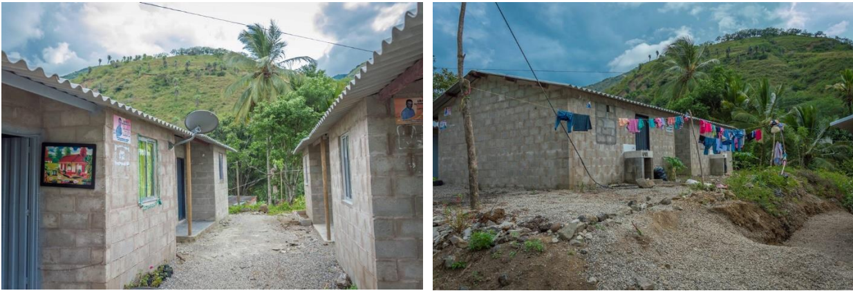
Figura 5.63. Vistas frontal y posterior de viviendas rurales sociales, Uramita
