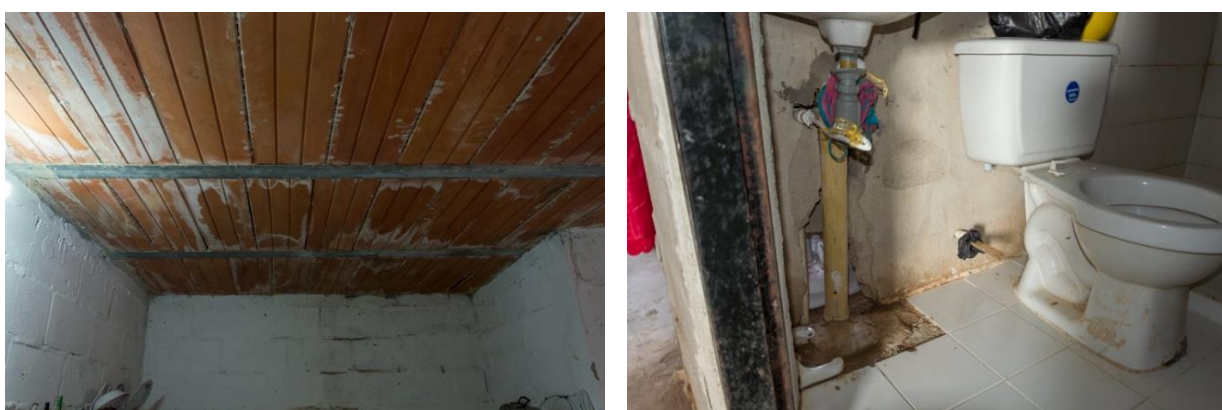
Figura 6.17. Problemas de instalaciones y filtraciones presentados en el conjunto n°5, El Bagre
