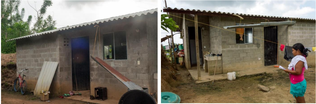
Figura 6.49. Recolección de aguas lluvias por iniciativa de la comunidad indígena de la vivienda n°1
