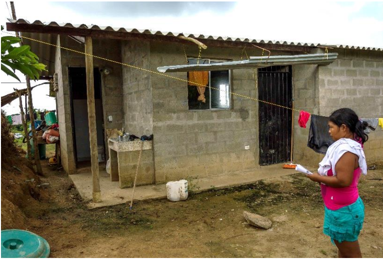
Figura 5.30. Vista posterior de la vivienda construida –Comunidad La Palma-
