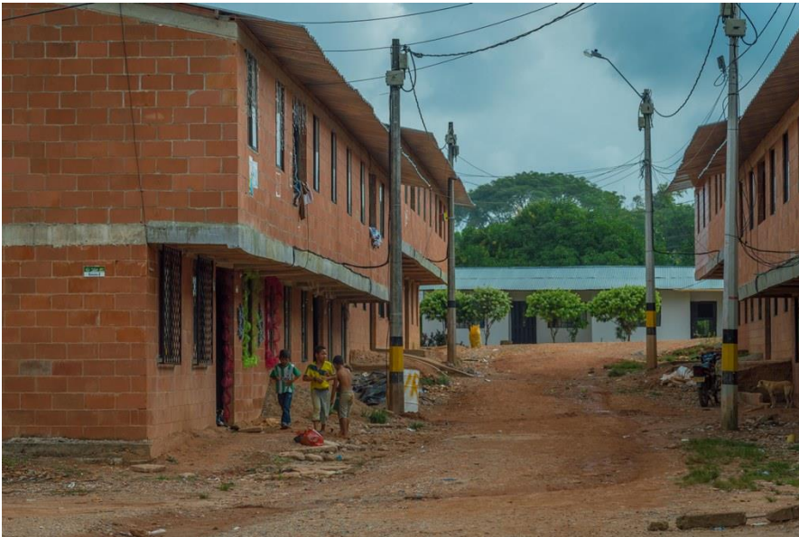
Figura 5.90. Vista 2 del conjunto Mirador de los Almendros
