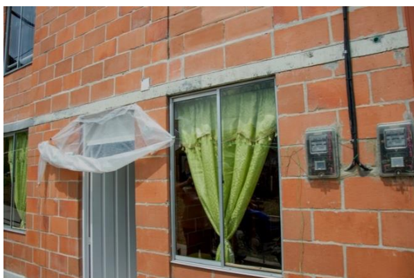
Figura 6.15. Filtraciones debidas a falta de alero en cubierta en el conjunto n°2, Fredonia
