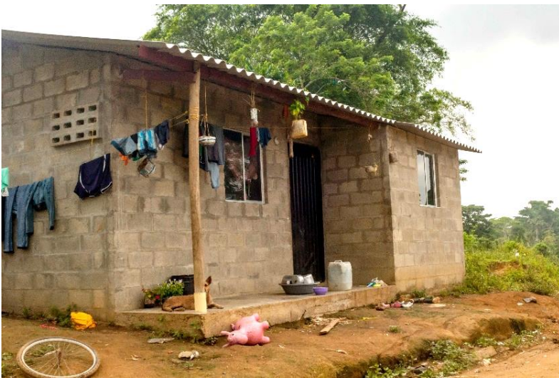
Figura 5.29. Vista frontal de la vivienda construida –Comunidad Ciakoro-
