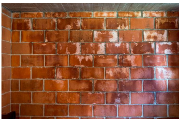
Figura 6.14. Humedades presentadas en los conjuntos n°2 y 4, Fredonia y Yarumal
