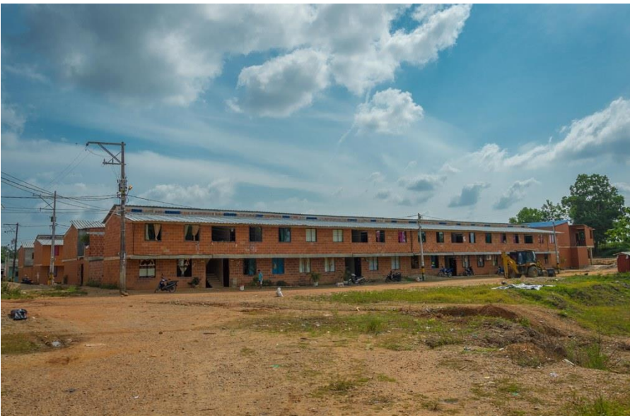
Figura 5.89. Vista 1 del conjunto Mirador de los Almendros
