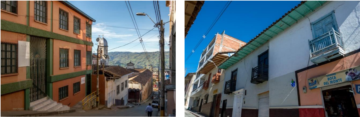
Figura 5.70. Construcciones aledañas al parque principal del municipio de Yarumal, Antioquia
