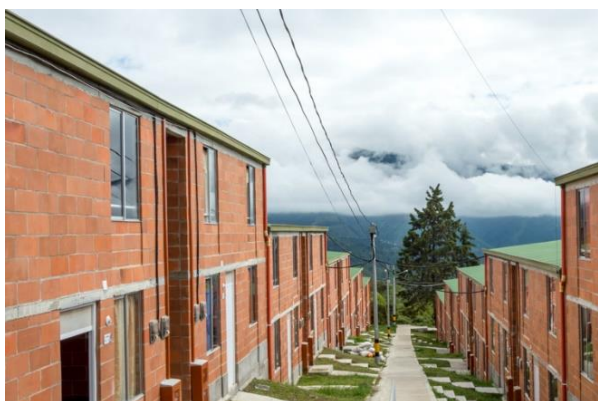
Figura 6.15. Filtraciones debidas a falta de alero en cubierta en el conjunto n°2, Fredonia
