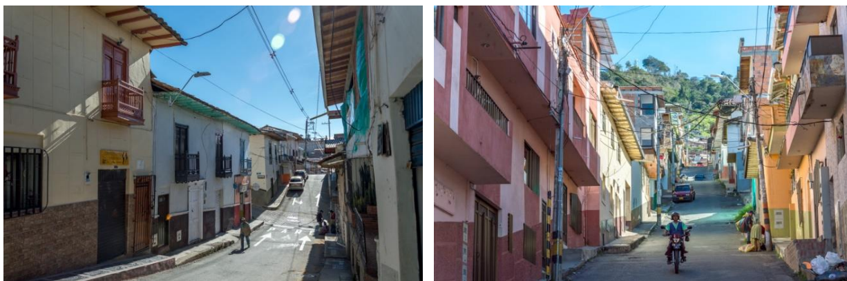
Figura 5.67. Calles del entramado urbano en el municipio de Yarumal, Antioquia
