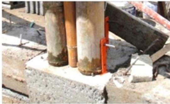
Pada bagian pondasi teknik dari struktur ini dengan cara tulangan besi yang berada di pondasi dikeluarkan  $\pm 1$  m dan dimasukkan kedalam bambu kemudian dicor secara bersamaan.
