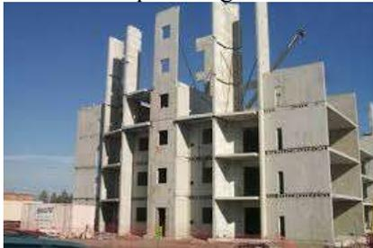
Gambar 16. Sistem modular/fabrikasi bangunan
