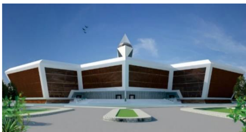
Gambar 21. Tampak depan bangunan utama Sumber : Analisis penulis, 2015
