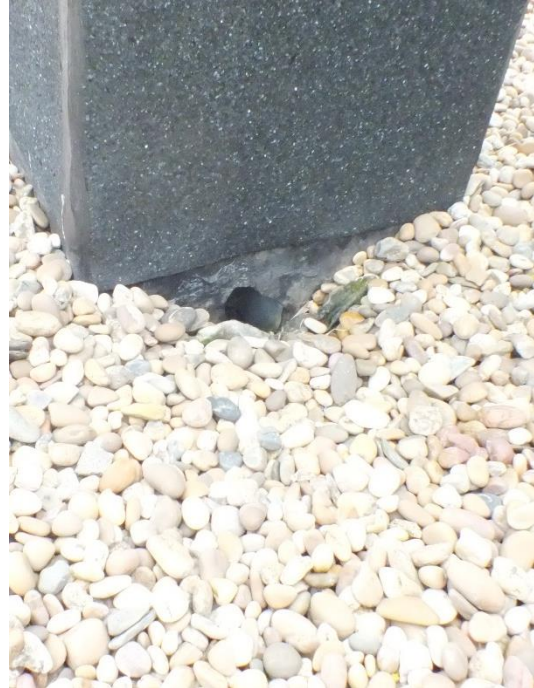
Fotografia 5: Saída de água
