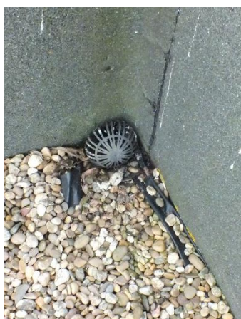
Fotografia 2: Saída de água
