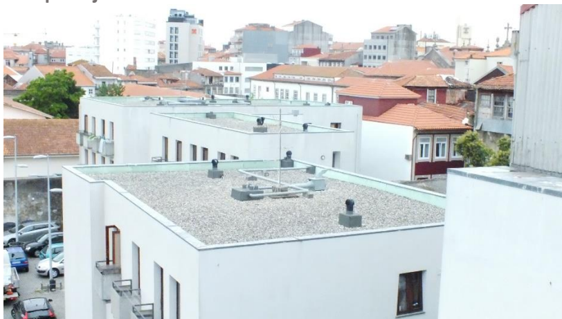
Fotografia 4: Vista do bloco D para as coberturas – blocos A, B e C
