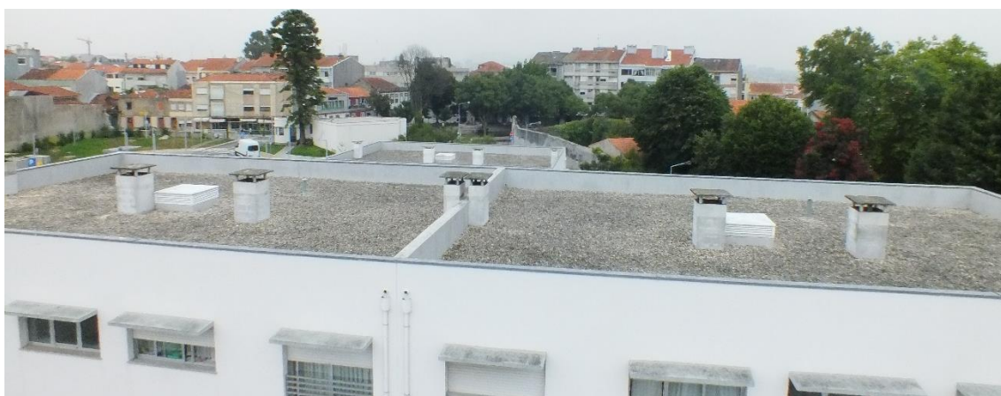
Fotografia 3: Vista geral da cobertura do bloco C
