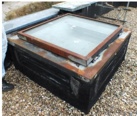
Fotografia 3: Clarábóia de acesso, exterior
