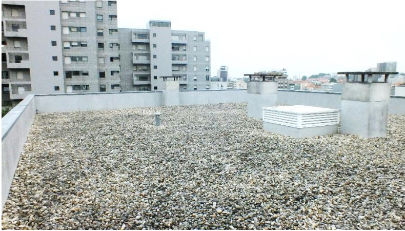
Fotografia 2: Elementos de ventilação e alçapão
