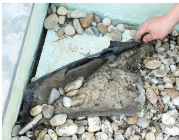
Fotografia 3: Camadas dos materiais da cobertura | Própria autoria
