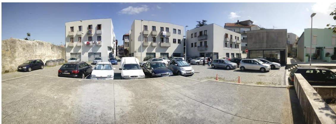
Fotografia 1: Panorâmica geral das fachadas do bairro das Fontainhas | Própria autoria
