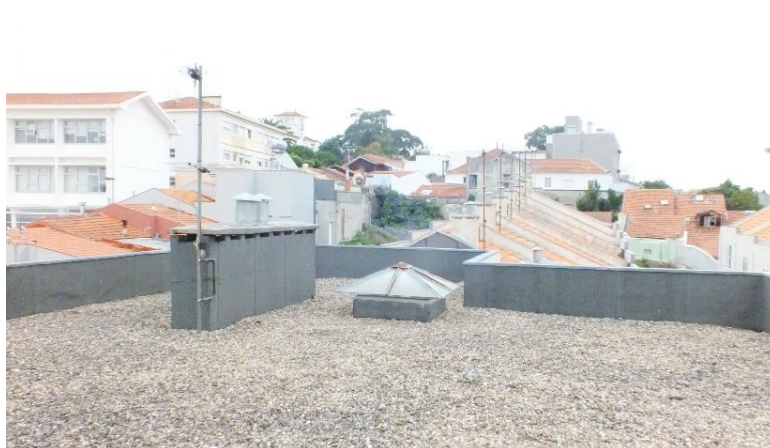
Fotografia 3: Clarabóia de iluminação (sem acesso), ventilação e antena
