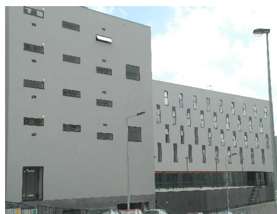
Fig. 26 - Fachadas Travessa de Salgueiros
