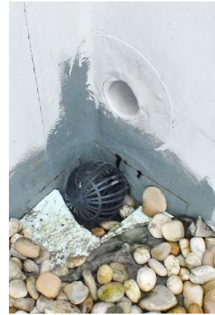
Fotografia 3: Saída de água
