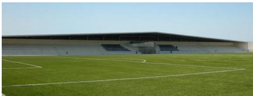
Figura 2 – Complexo Desportivo de Custóias. Fonte: www.thefinalball.com/img/estadios/884/309884_med__20160104114203_estadio_custoias_futebol_clube.jpg
