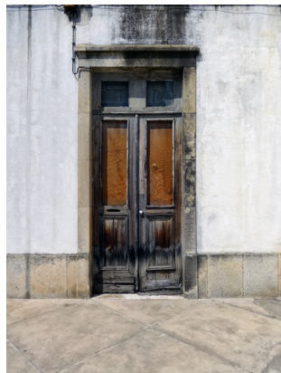
56, 57, 58. Degradação dos rebocos e caixilhos | Paredes exteriores e Caixilharia
