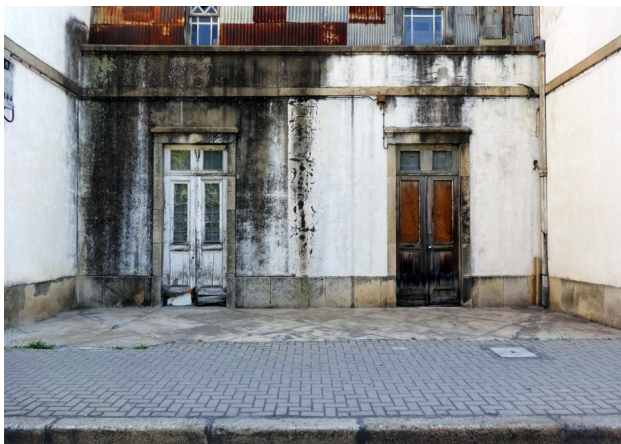
54, 55. Degradação e fendilhação das paredes exteriores | Paredes exteriores
