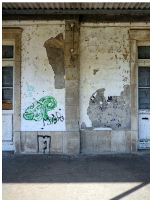
56, 57, 58. Degradação dos rebocos e caixilhos | Paredes exteriores e Caixilharia
