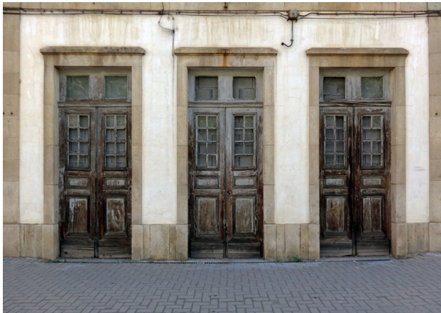
43, 44. Vãos de acesso ao interior | Caixilharia exterior
