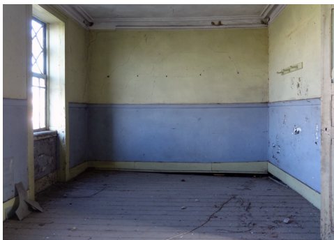
59, 60. Degradação dos pisos e expansão do pavimento | Pisos
