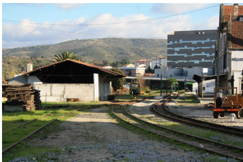
10. Chegada ao Edifício da Estação de Caminhos de Ferro | Mirandela
