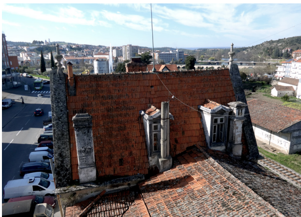
61, 62. Degradação das telhas e presença de fungos e ervas | Cobertura
