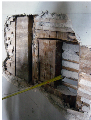
49, 50, 51, 52, 53. Sistema construtivo da caixa de escadas helicoidal | Caixa de escadas
