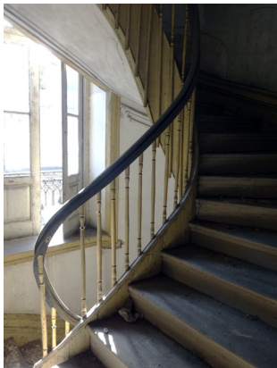
29. Escadas acesso aos pisos | Piso 2
